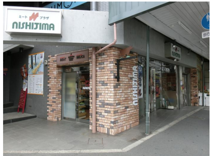
ミートプラザニシジマ外観
